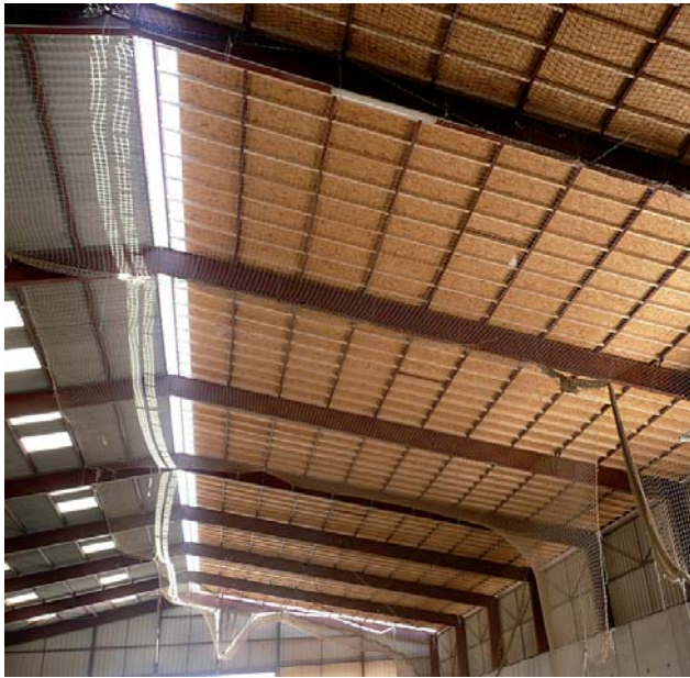
Lagerhalle, Montage der Unterkonstruktion
