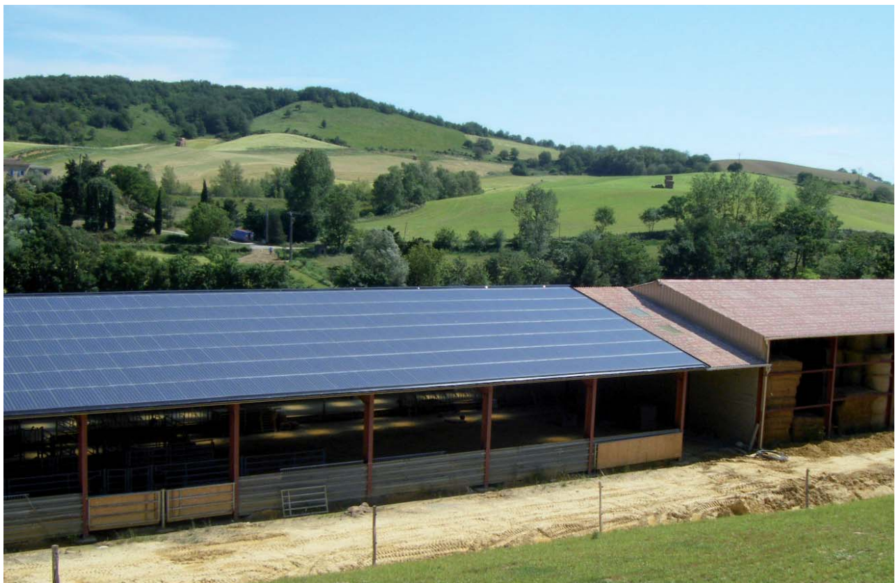
Lagerhalle, dachintegrierte Photovoltaikanlage
