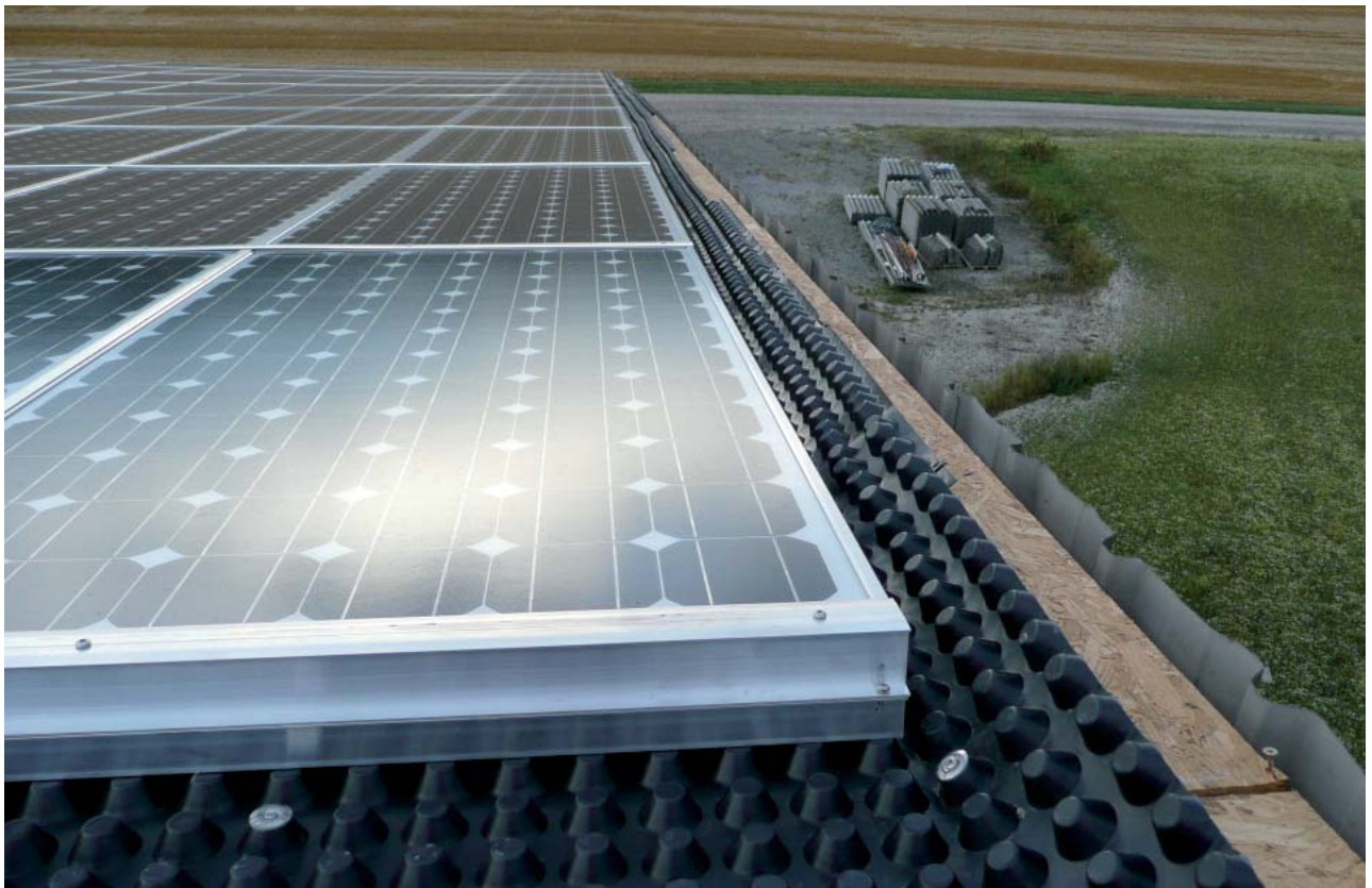
Lagerhalle, Montage der Module
