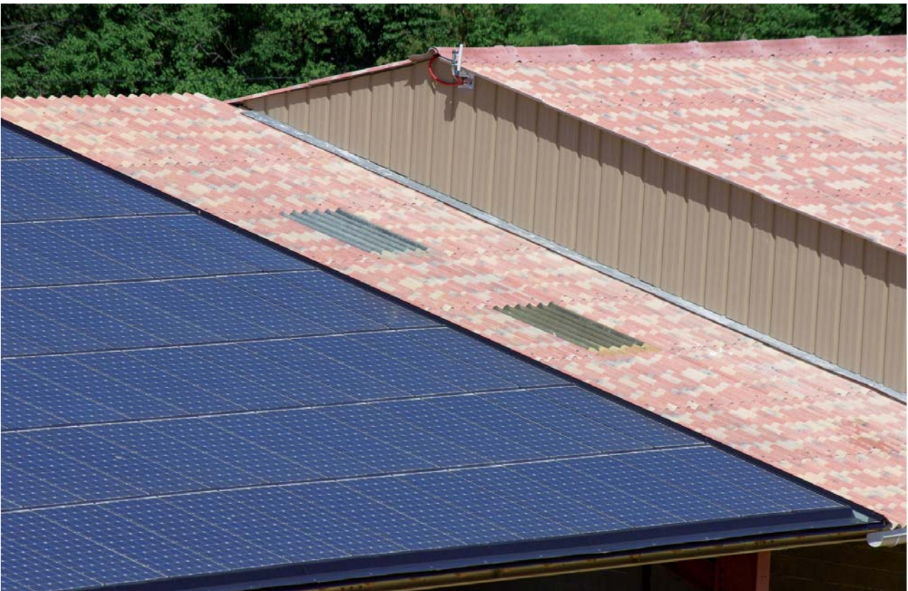
Lagerhalle, dachintegrierte Photovoltaikanlage
